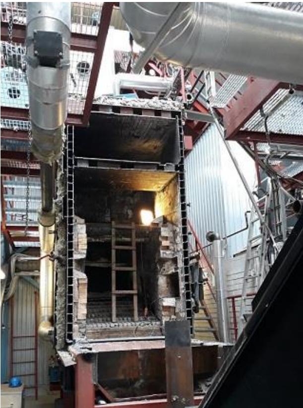
Kuva 9. Tulipesä ilman konvektiota
