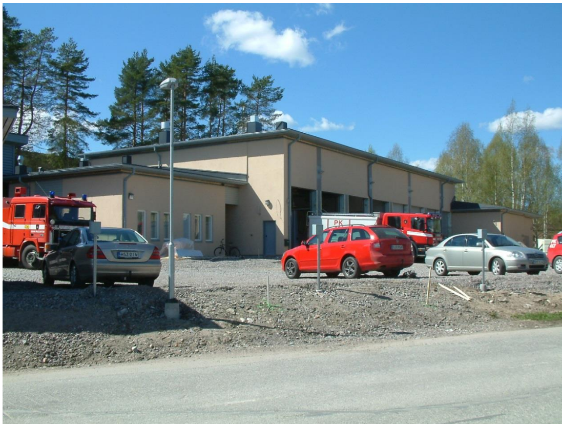
Palo ja pelastustoimen tehtävistä vastaa edelleen Pohjois-Karjalan pelastuslaitos joka on parhaillaan muuttamassa saneerattuihin ja uusiin tiloihin. Kuva: R. Alanko
