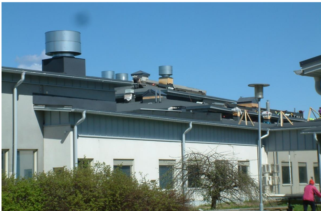
Kunnan mittavin rakennuskohde arviointivuonna oli Juuan terveystalokeskukseen vesikaton uusiminen ja investointiin liittynyt tehostetun palveluyksikön laajennus joka kokonaisurakkahinta on noin 4,9 miljoonaa euroa. Kohde valmistuu syksyllä 2015. Kuva: R. Alanko
