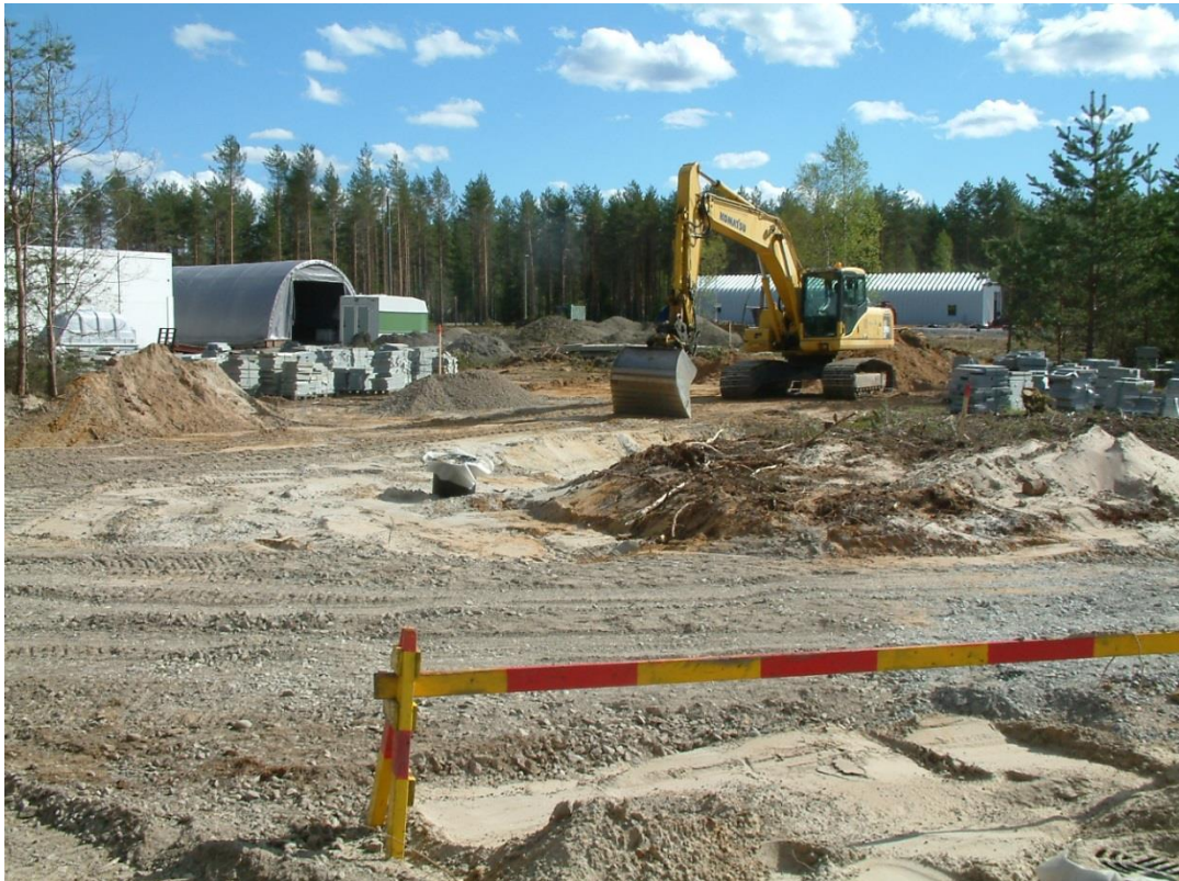
Kunnallistekniikan valmistuttua uuden Turunkankaan teollisuusalueen rakentaminen käynnistyi välittömästi. Kuva: R. Alanko.
